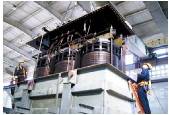
Reparación transformador de salida, Central Gabriel Terra
