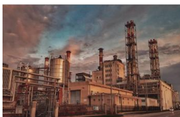
Central Térmica de Motores
