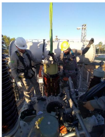
Fotografía 2 – Extracción del CBC
