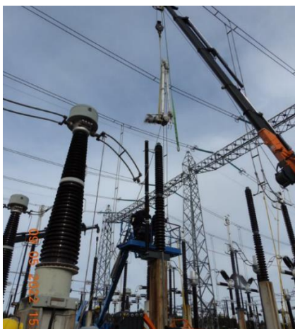
Fotografía 1 – Renovación de seccionadores de 500kV
