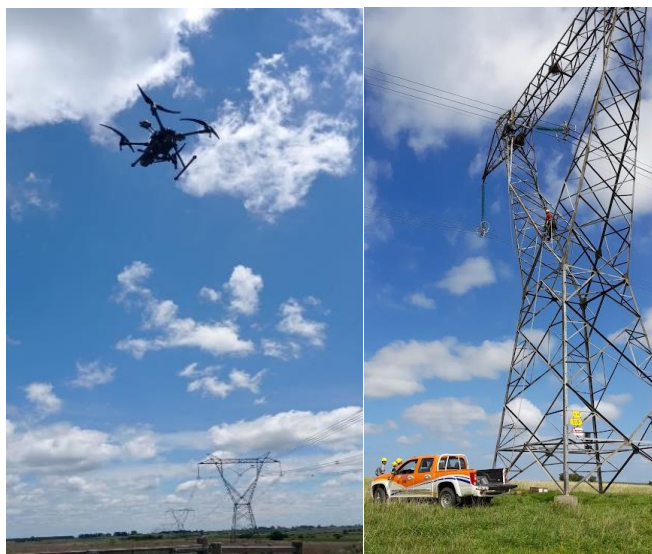
Fotografía 3 – Inspección con drones y sustitución de cadenas de 500 kV
